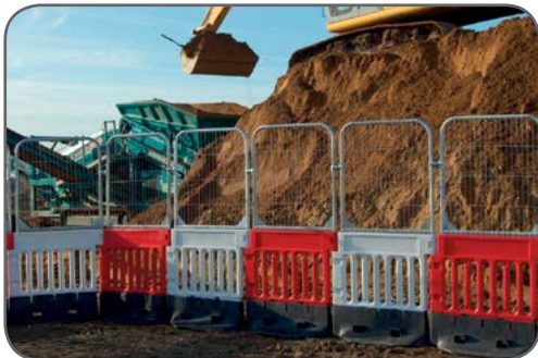
Barreiras para contenção de terras
